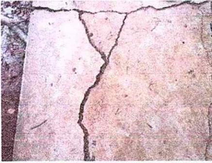
Foto 7: Se reparará una parte del corredor, ya que la torta de cemento esta totalmente debilitado.
