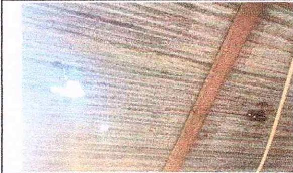
Foto 9: La estructura de madera del techo de la dirección se va cambiar a costanera de metal de 2x3.
