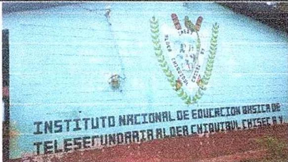
Foto 11: La pintura de las paredes del centro educativo se ve en mal estado, se pintará con una pintura de buena calidad.
