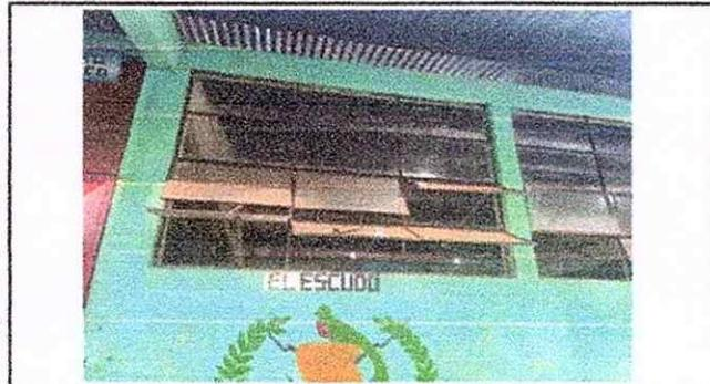
Foto 3: Las ventanas se convertirán el corrediza ya que dificulta instalar balcon.
